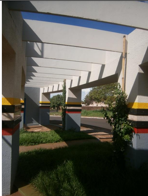
Pergolado da Praça, 23 de Novembro de 2017. Fonte: Ariely Souza Ferreira. Arquiteta e Urbanista.
